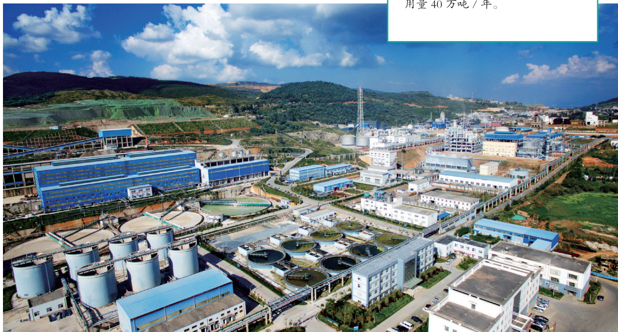
磷化集团晋宁 450 万吨/年浮选装置
